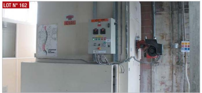
▶ **Chaudière à air pulsé SBTC**, type TC9BI, N° 1418-52, année 2001, puissance 660 kW, débit d'air 30000 m³/h avec brûleur gaz SIGMA
